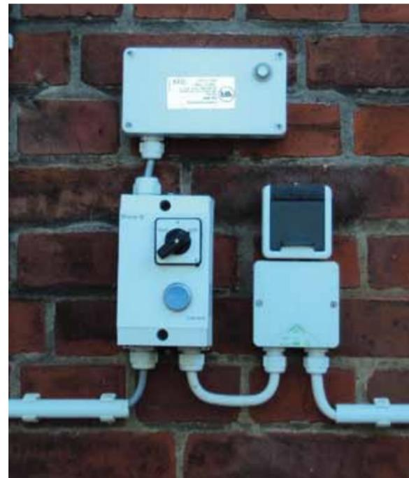
Funkfernsteuerungsempfänger mit Motorschutz
